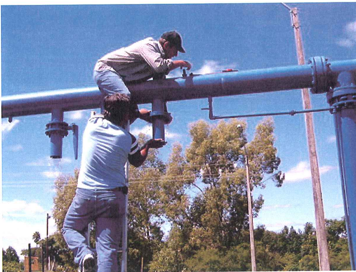
INSTALACIÓN DE MANÓMETRO EN O.S.E.
