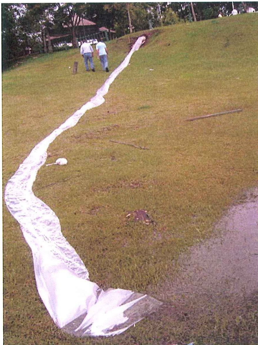
CONTROL DE EROSIÓN POR DESAGÜE EN REMEROS (1)
